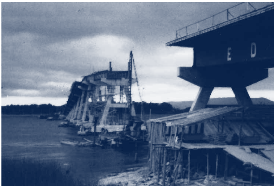
Imagen 1: Construcción del puente Cruces. Fuente: González, 2013, p. 53.
