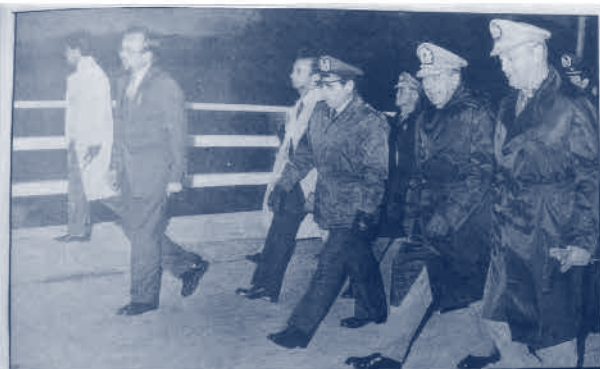
Gratamente impresionado por la obra del Puente Cruces se mostró el Presidente de la República, que una vez terminada la ceremonia con que se inauguró el viaducto, hizo un recorrido por él, acompañado, entre otros, por el ministro de Obras Públicas, Bruno Siebert, el intendente general de brigada aérea, Jorge Hurtiaga, el gobernador, Eduardo Urrutia, y el alcalde, Eduardo Schild.
