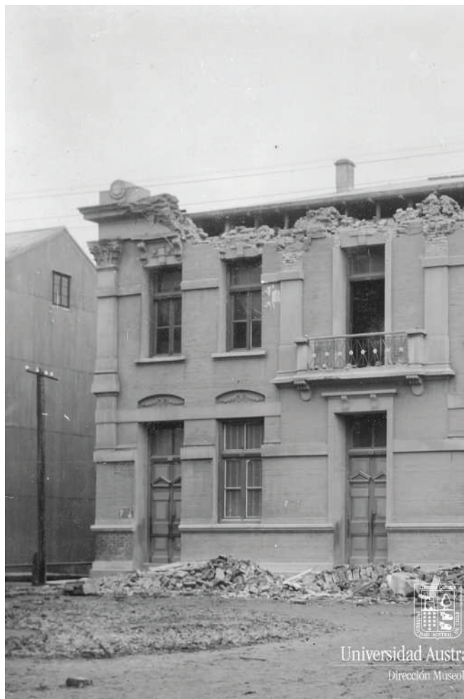
Figura 3. Edificio de la Notaria, la Aduana y la Tesorería Fiscal con graves daños.
