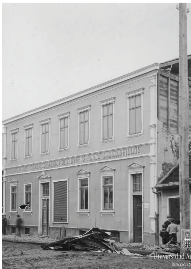
Figura 1. Derrumbe de una muralla de cortafuego sobre una casa habitación.
