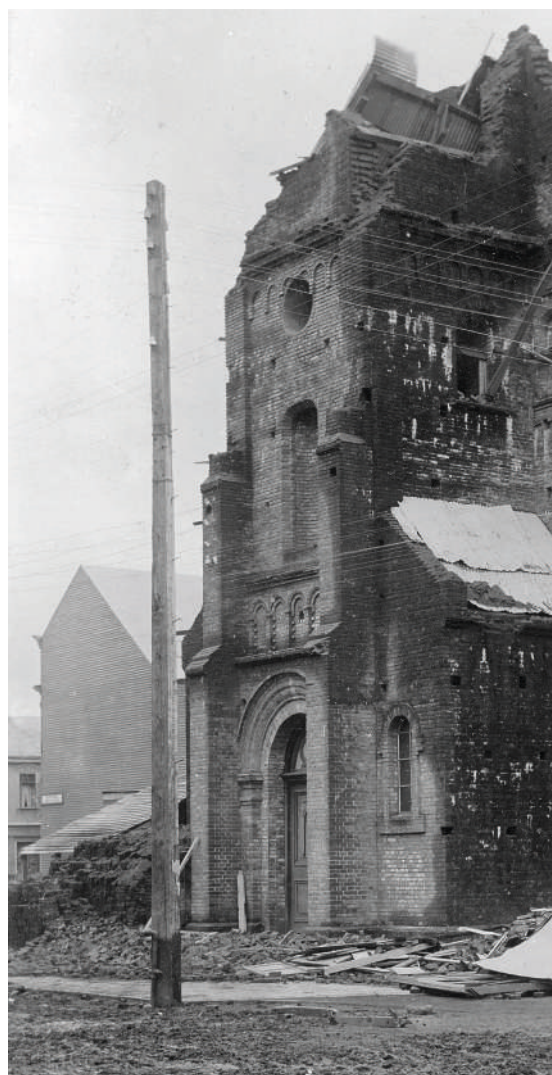
Figura 2. Iglesia Matriz de Valdivia con su torre derrumbada.
