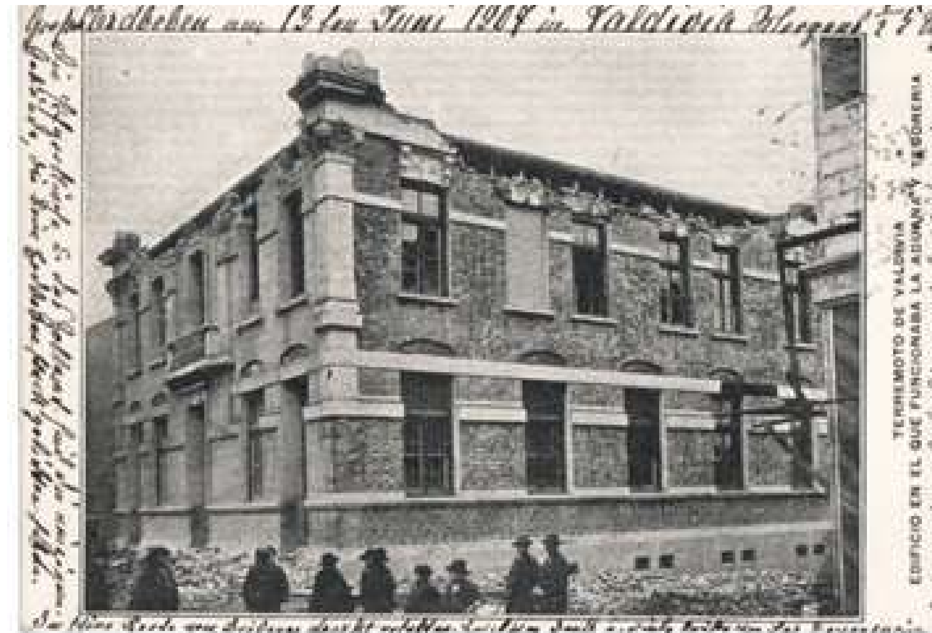
7 Terremoto de Valdivia. Edificio en el que funcionaba la aduana y tesorería. Sin autor. 1907. Fuente: Chile Collector.
