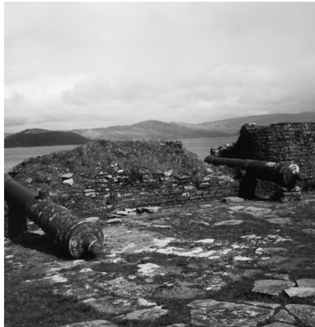
c.1968. Merlón destruido
