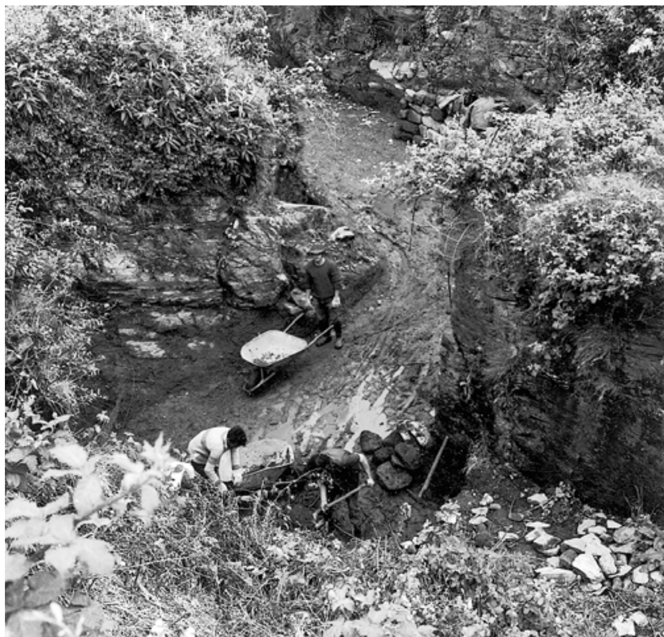
1972. Limpieza del foso
