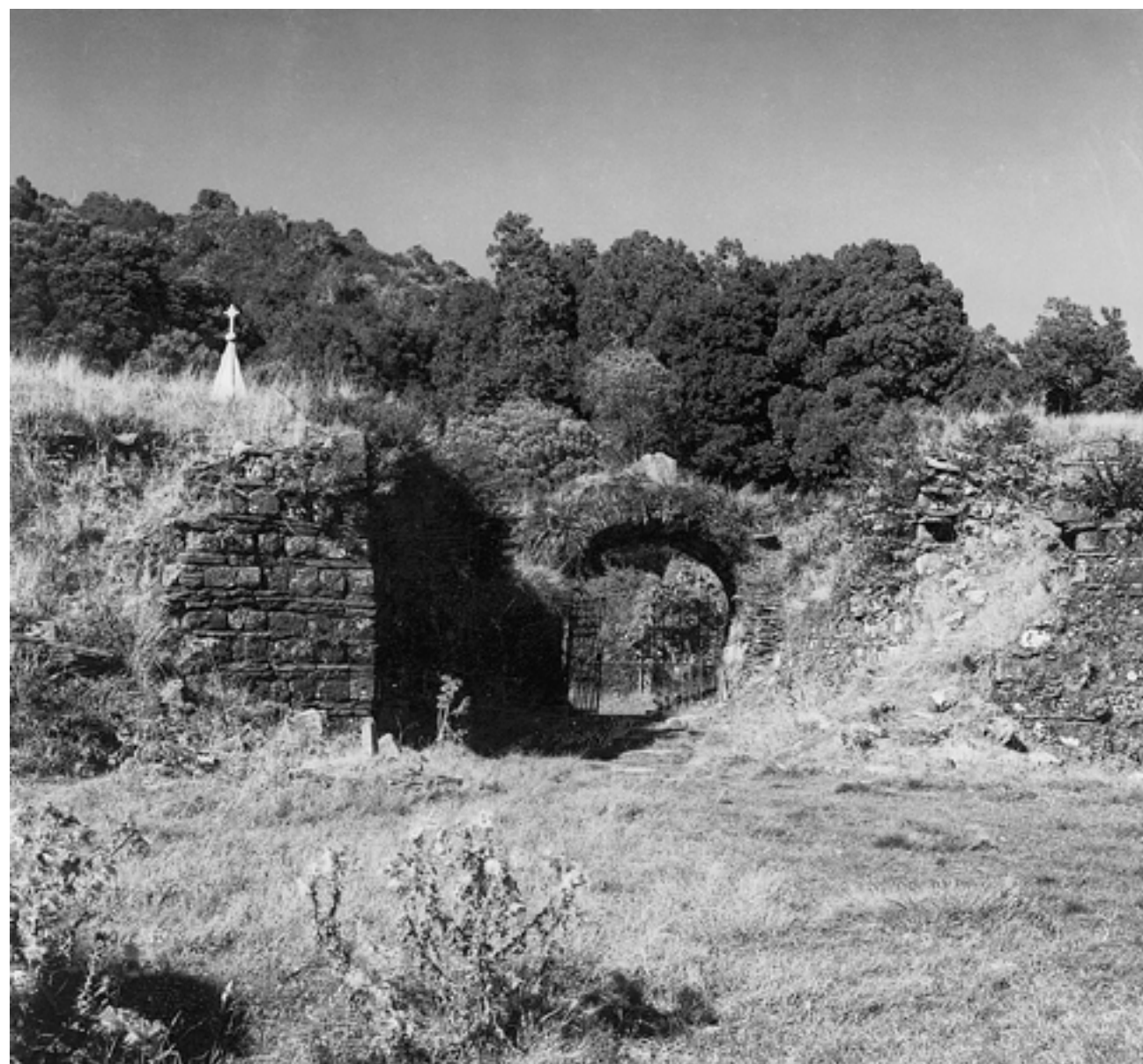
c.1968. Zaguán de acceso desde la explanada
