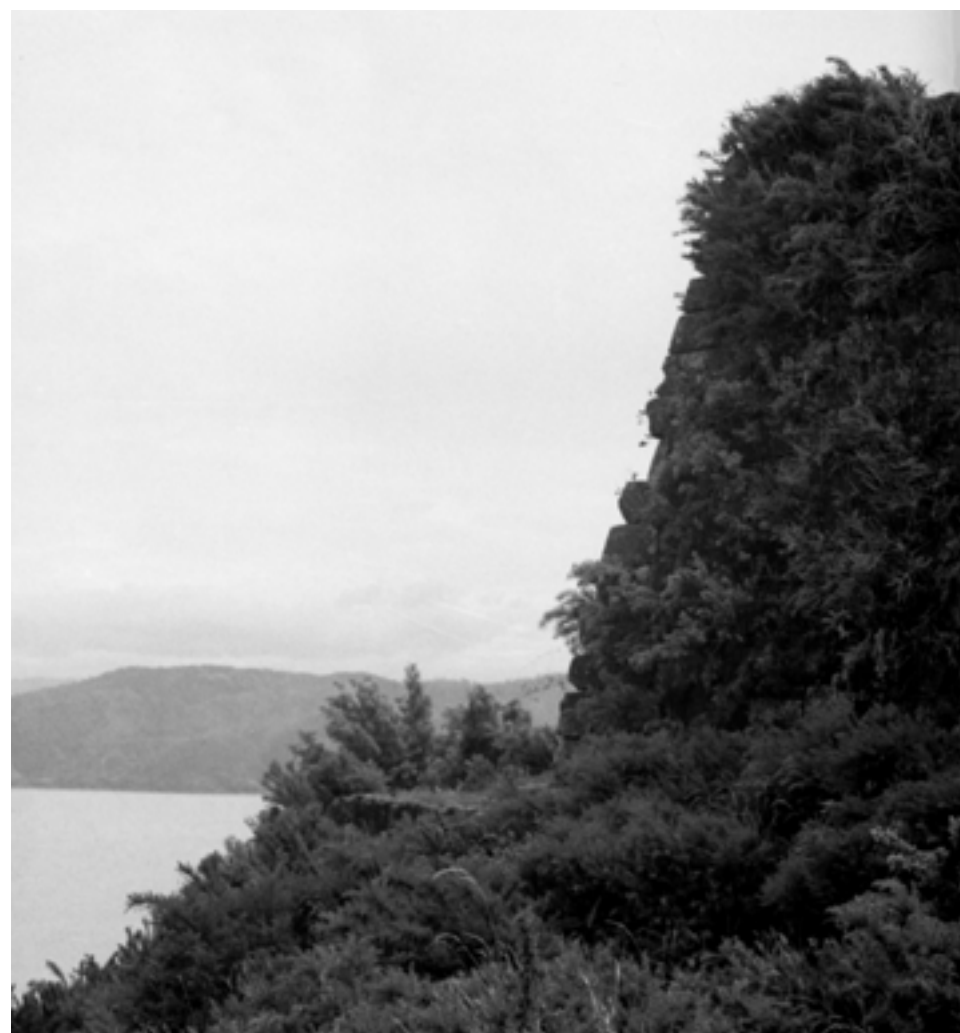
1949. Perfil de muro y baluarte sur antes de la limpieza
