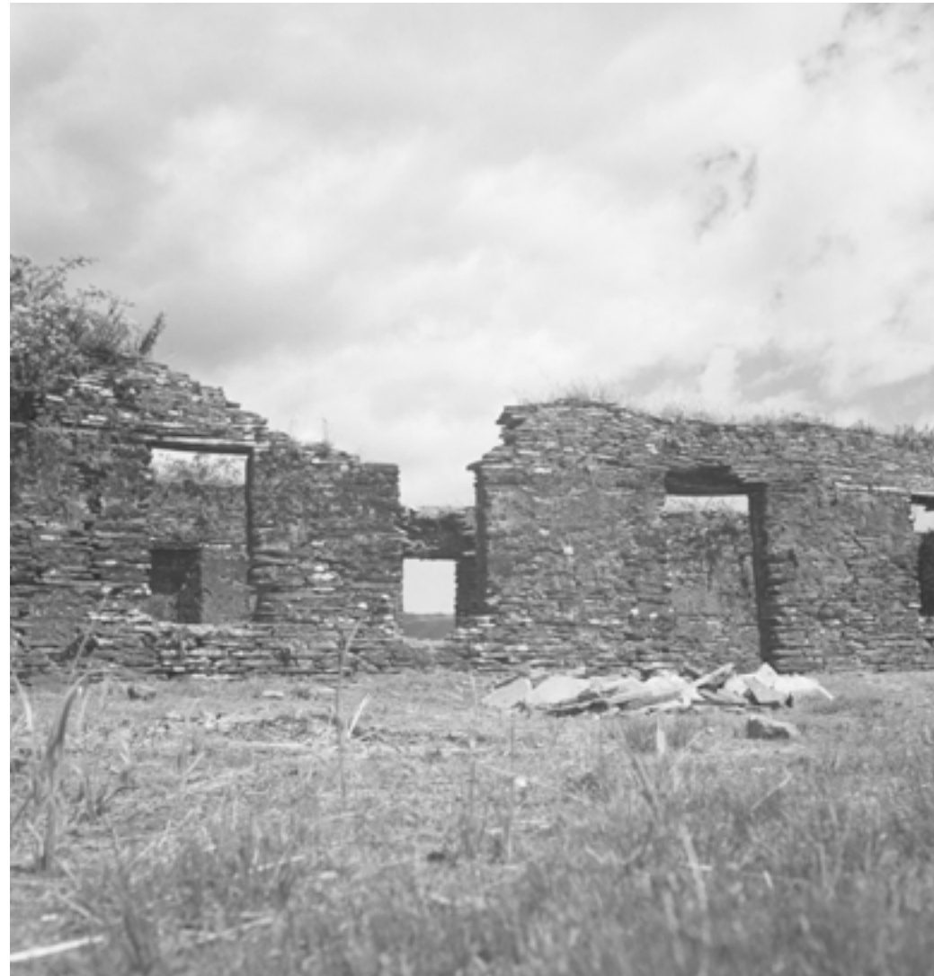
c.1953. Muro dañado de la Casa del Gobernador
