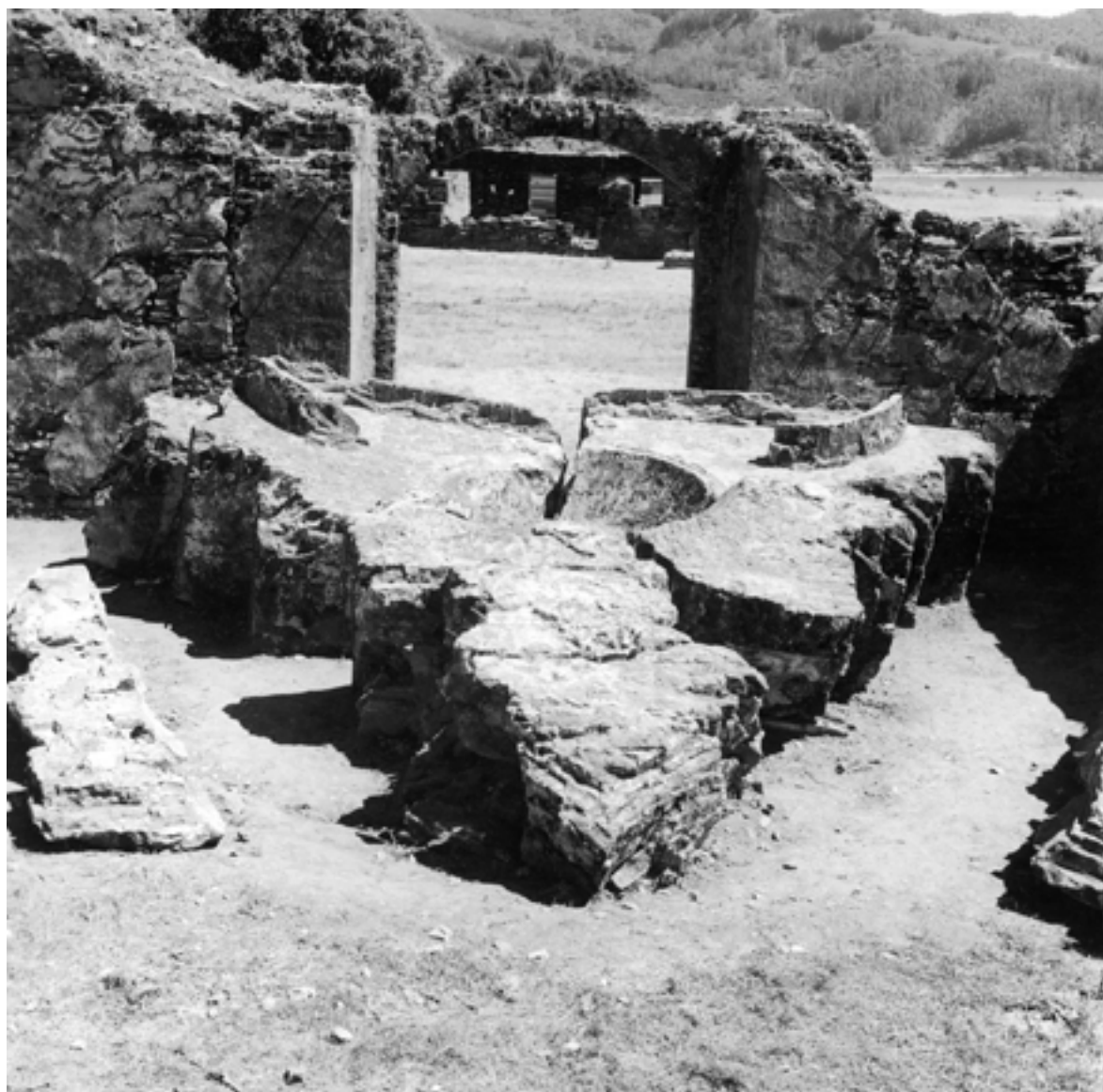
c.1972. Hastial de la iglesia en el suelo de la nave
