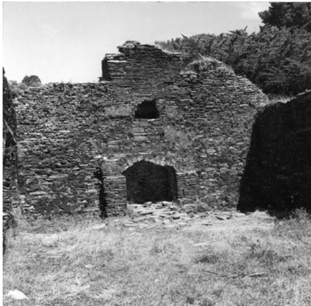
c.1972. Muro y chimenea de la Casa del Gobernador
