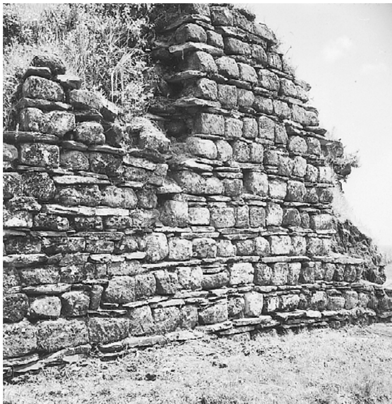
c.1968. Muro del zaguán y sus daños
