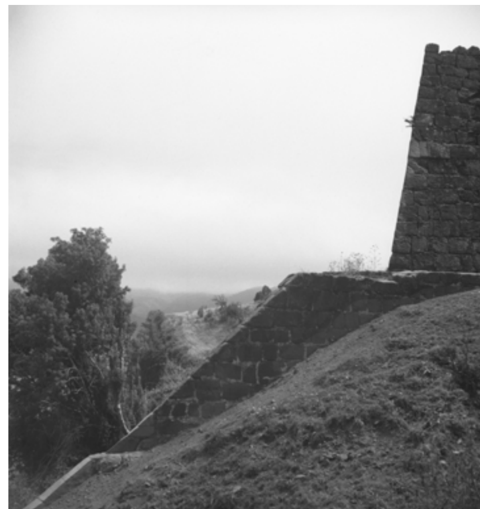
c.1953. Perfil de muro y contrafuerte del baluarte sur restaurado
