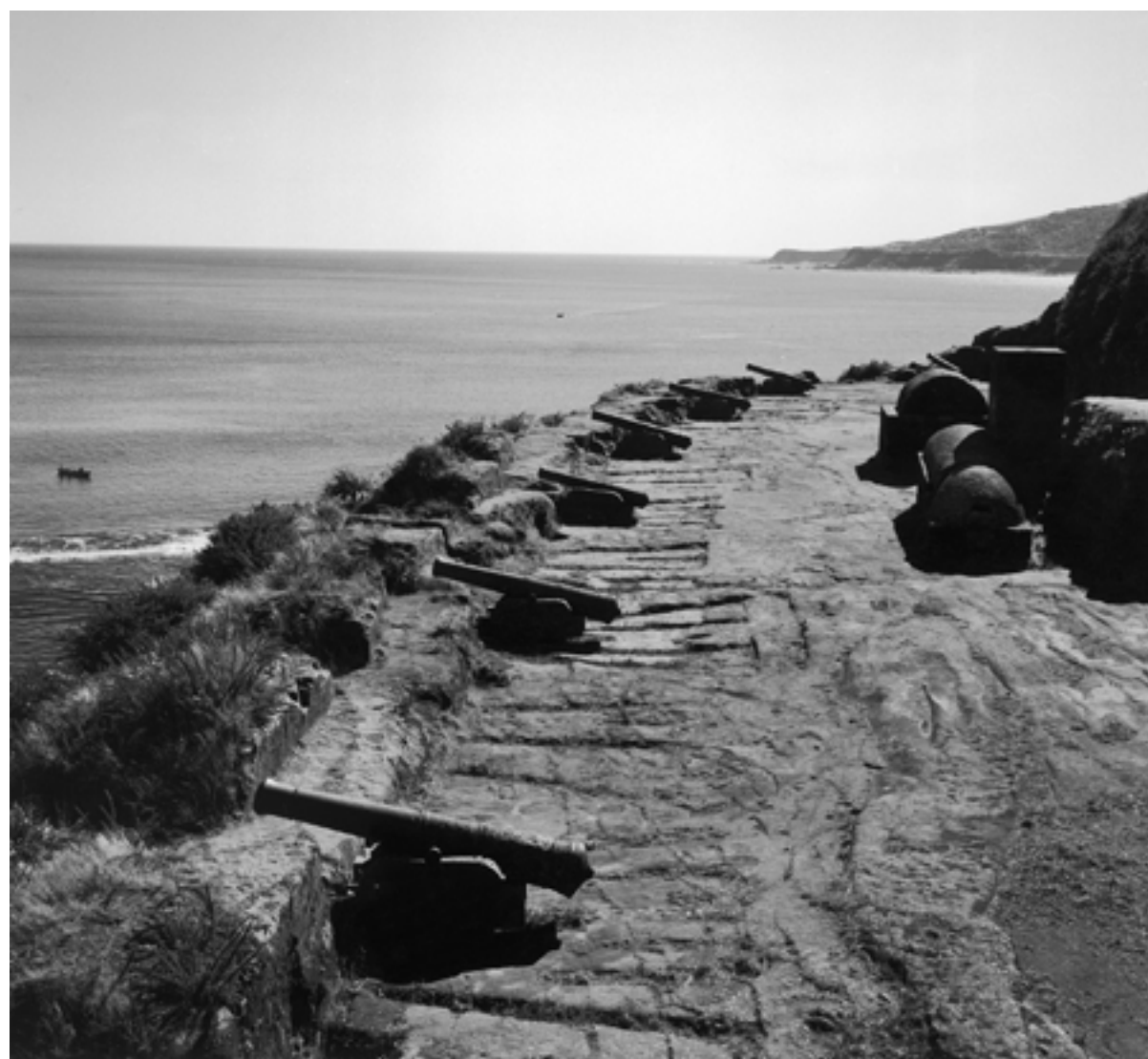
c.1972. La batería y sus merlones dañados
