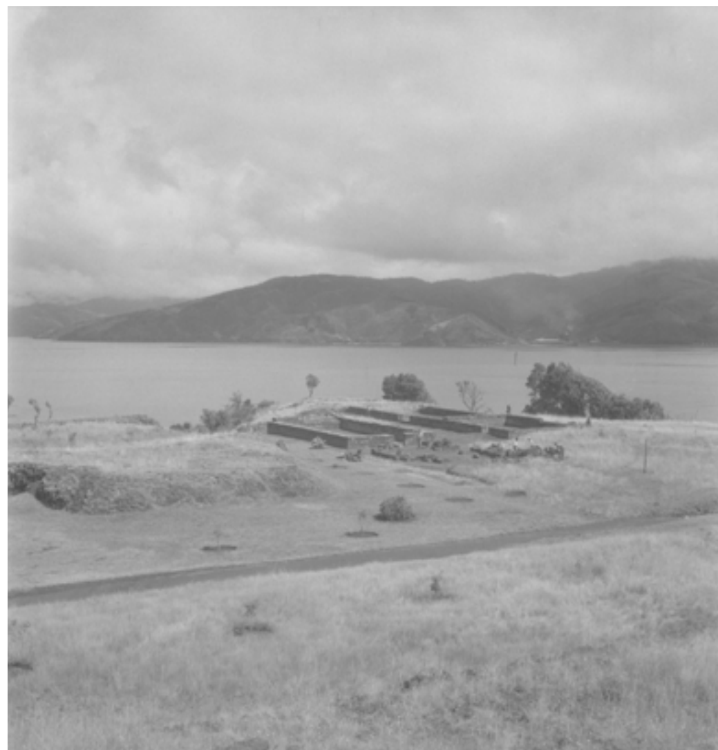
c.1954. Vista general de los trabajos en la explanada
