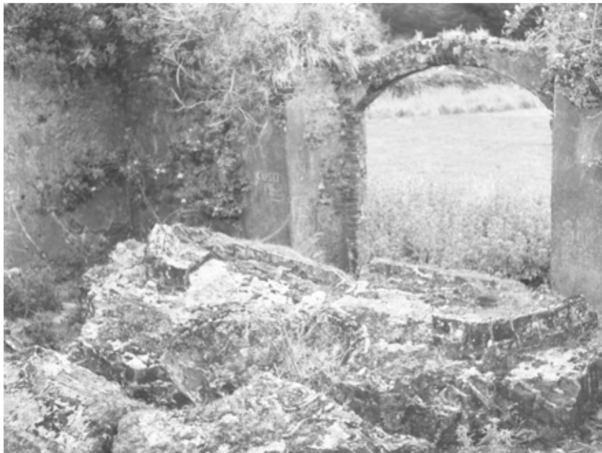
c.1948. Restos del muro de fachada de la iglesia
