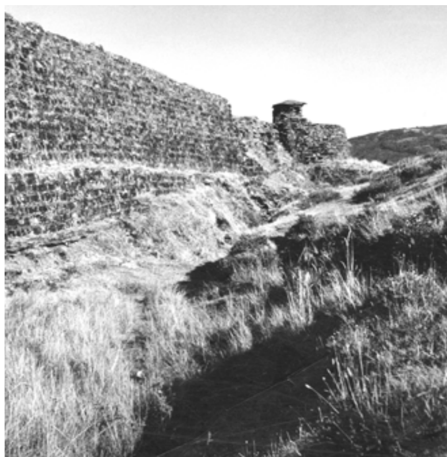
1954. Limpieza en muro de defensa y foso
