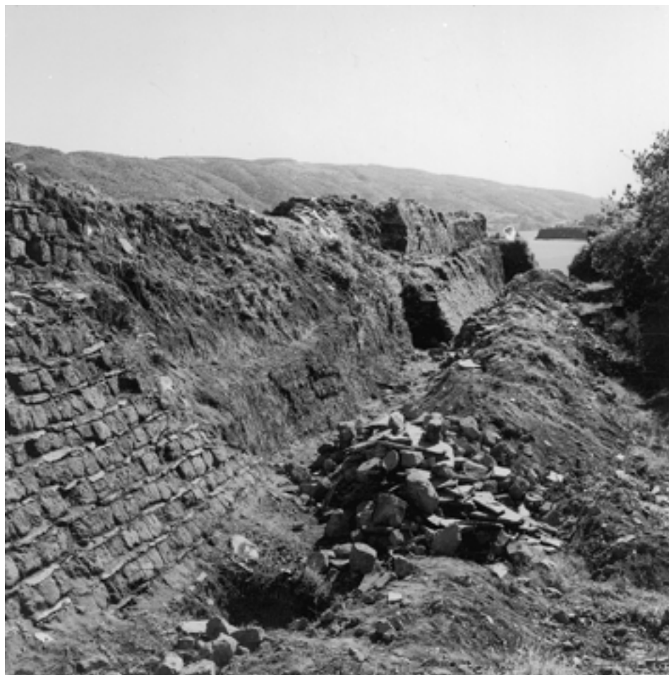
c.1972. Muro de defensa y foso con sus daños
