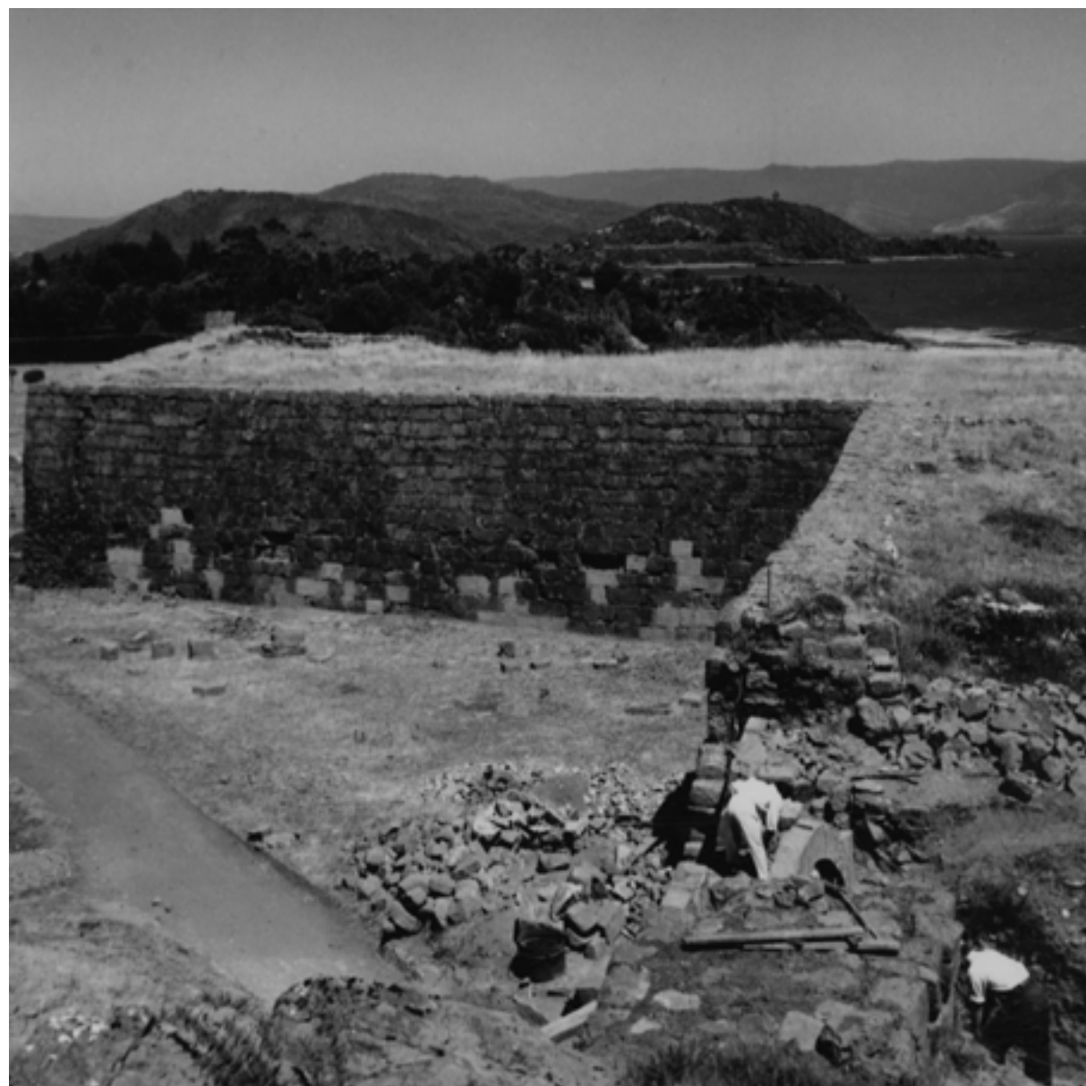
c.1952. Injertos en la gran muralla y arreglos en el acceso al castillo
