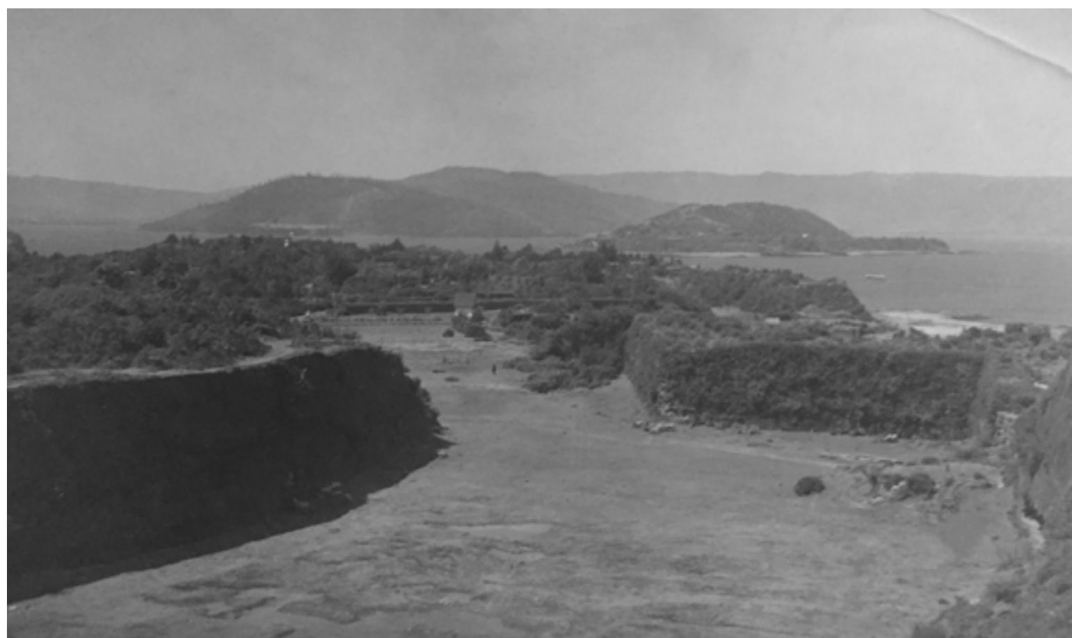
c.1945. El foso y la gran muralla antes de los trabajos
