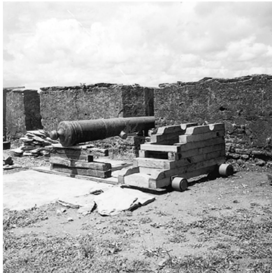
c.1970. La nueva cureña en proceso de montaje
